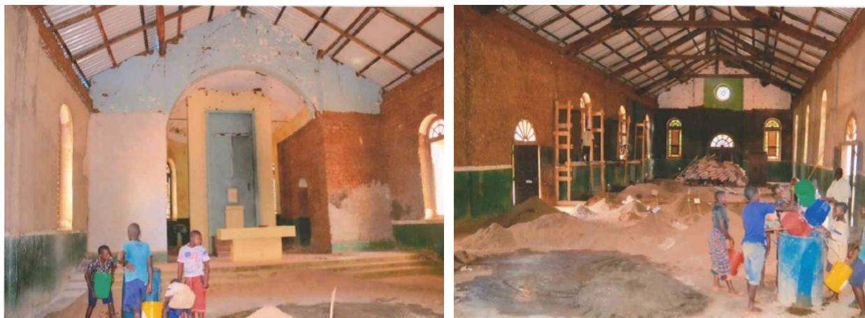
I lavori di manutenzione alla chiesa di Singisa
